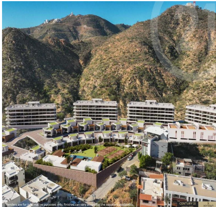
Fachada y área de alberca
